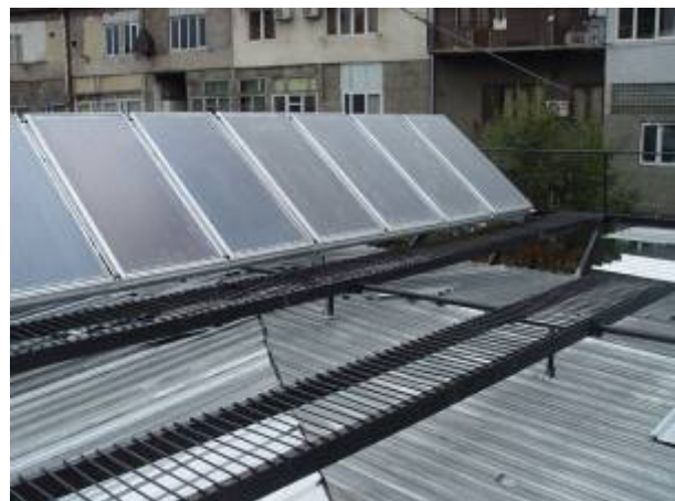
Խանջյան 43 կաթսայատան արևային ջրատաքացուցիչների ընդհանուր տեսքը
