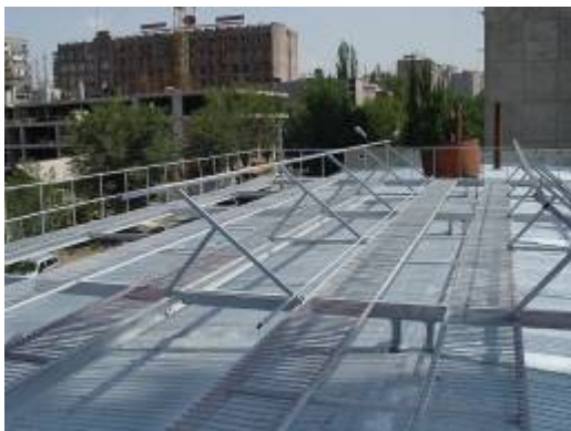
Ավետիսյան 70 կաթսայատան արևային ջրատաքացուցիչների հենարանային մետաղական կոնստրուկցիաները
