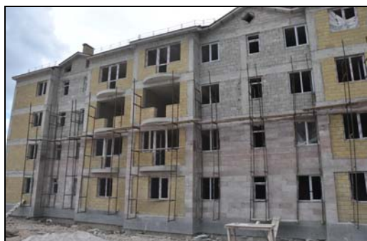
Строящийся многоквартирный дом в квартале “Муш-2”
